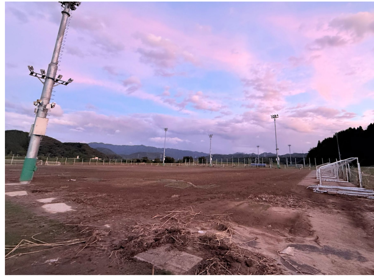
熊本甲佐総合運動公園 2025年8月21日18:00ごろ 人工芝ピッチは全般的に土砂が堆積
