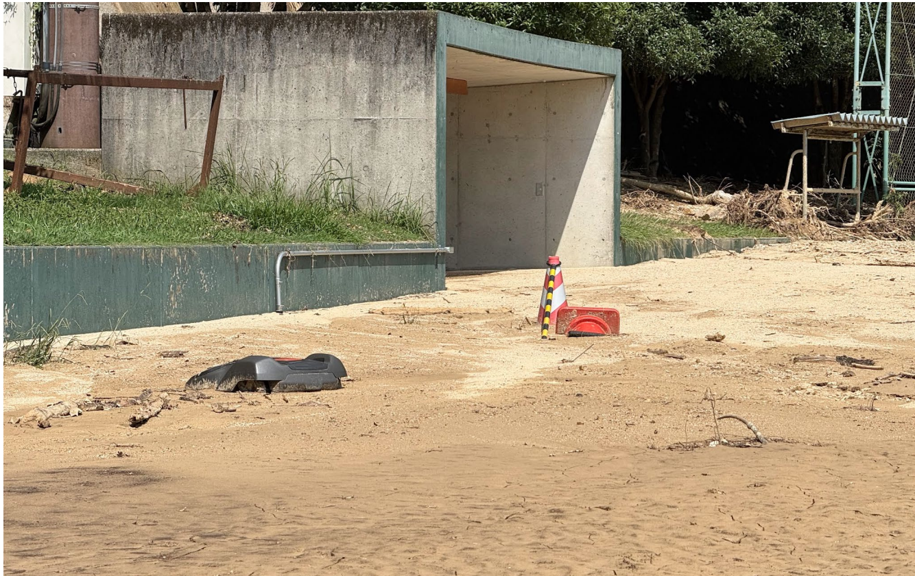
宇城市観音山総合運動公園 2025年8月16日14:00ごろ 自動芝刈り機の設置場所を含む天然芝に土砂が覆い使用不可
